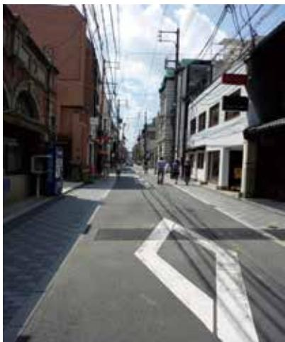
寺町から新町の間の三条通の道路の舗装が数年前、新しいデザインに施された。道路幅員が約7mのうち約1.5mの歩道が両サイドに2本。西行一方通行の車道がセンターに走る。この構成は他の同じような幅員の道路と変わらないが、歩道部分の舗装がグレーと白色の煉瓦サイズのタイルが貼られている。歩道と車道間には高低差はない。無理の無いデザインである。このデザインによって、しだいに自然と車両の走行や店先の駐車を遠慮したりして、歩行者が道路全体をゆっくり歩けるようになった。軒並み店舗が活気を取り戻し新しい京都観光のストリートになり、終日歩行者で賑わっている。
