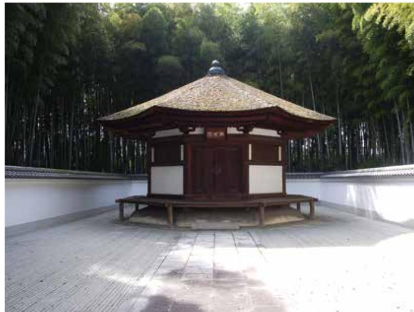
広隆寺境内の上宮王院太子殿の西、境内西北角に位置し、聖徳太子が楓別宮を起こした場所と伝えられ、1251年（建長3年）中觀上人によって再建された。別名八角堂という。単層檜皮葺八柱造りの鎌倉建築で、屋根に八角形の＜露盤・宝珠＞を載せている。屋根勾配は非常に緩くて、軒の反りは強く、廻縁が広くて見附が薄いため、軽快で安定した印象を受ける。大改修を施されているが当初の面影を留めて、夢殿形式の典型といわれ清雅な建築美を誇っている。度々の災禍にも拘らず、多くの仏像（国宝仏像17躯）がよく保存されていたことからも、強い信仰の対象として大切にされていた事が分かる。
