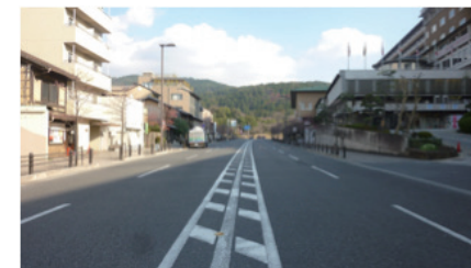
電柱の無い三条通
