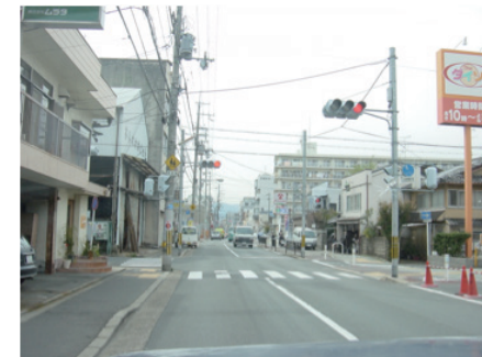
写真右手には自転車通行注意柵が見える
